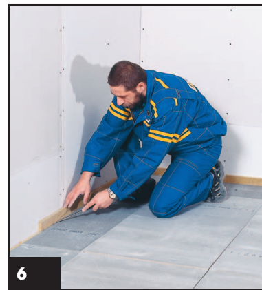
6 Seřiznutí izolačního pásku, případně pojistné hydroizolace.
