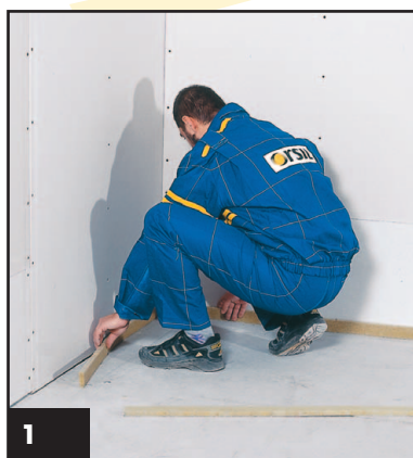
1 Položení izolačního pásku Orsil N/PP po obvodu místnosti.
