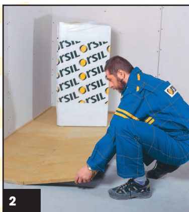
2 V rohu místnosti se na sraz kladou izolační desky Isover TDPT nebo Orsil T-P.
