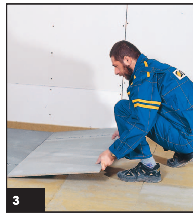
3 Pokládka první vrstvy cementotřískových desek, začíná v rohu místnosti.
