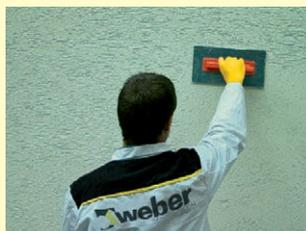
Struktura se vytváří plastovým hladítkem ihned po nanesení. Tahy hladítkem musí být stejnoměrné v celé ploše, zvláště v místech koutů, úrovní podlážek lešení apod.
