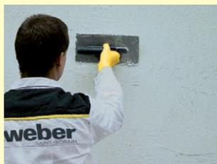
Omítka se nanáší na podklad nerezovým hladítkem na sílu vrstvy danou velikostí zrna. Omítku je třeba napojovat ještě před jejím zavnutím takzvané „do živého“. Ucelené plochy provádět bez přerušení.
